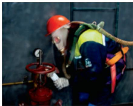
Выполнение квалификационно-пробной работы «Техническое обслуживание запорной арматуры газового колодца».
